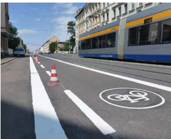
Abb 21: Begleitung der Markierungsarbeiten in der Georg-Schumann-Straße
