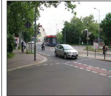
Sanierter Abschnitt am Coppiplatz
