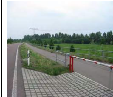
Abschnitt ohne Lärmschutz
